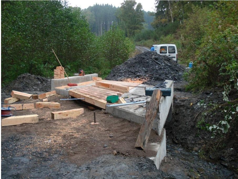
Bild 3: Einbau der Brücke
