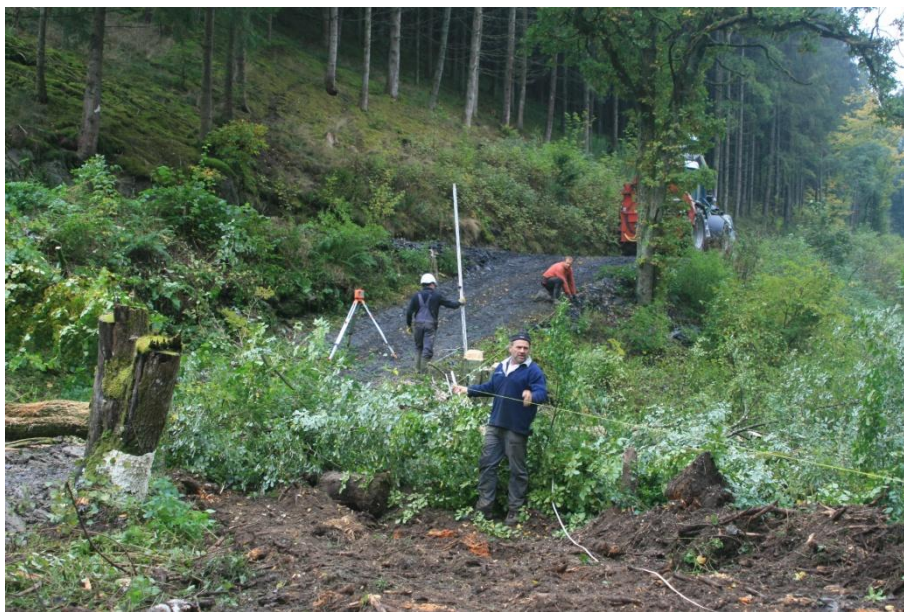
Bild 5: Ausmessen der Baustelle
