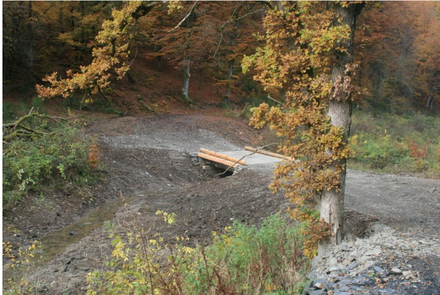
Bild 9: Blick vom Hauptforstweg auf die fertige Brücke
