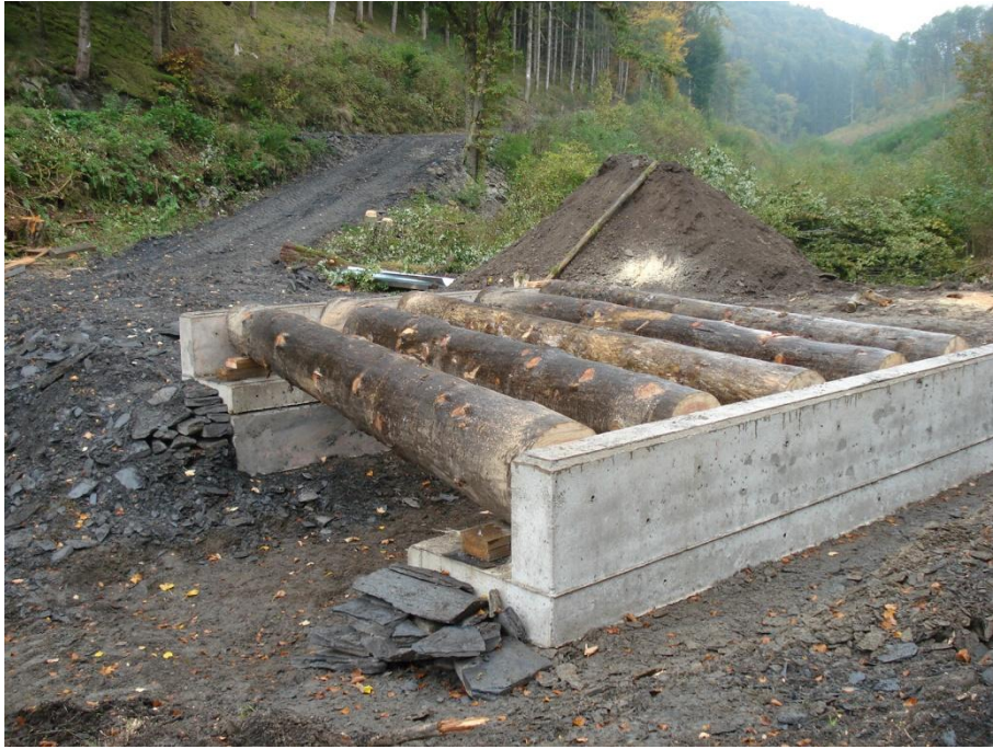
Bild 7: Bau der Brücke während der Bach noch durch das Rohr fließt
