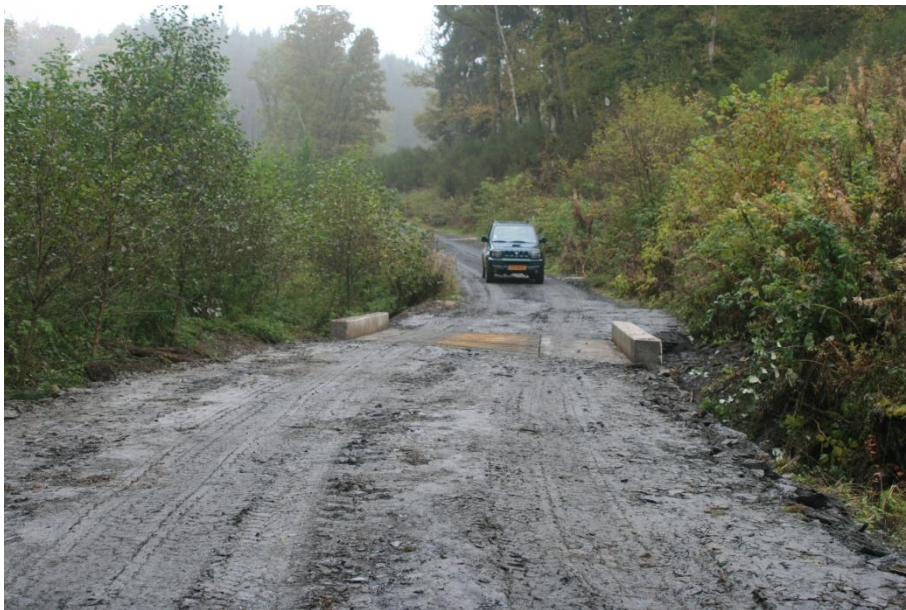
Bild 4: Fertigstellung der Brücke
